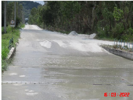
รูปที่ 2-16 บ่อล้างล้อรถบรรทุกแร่
